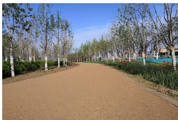
再生混合料铺筑园区道路
