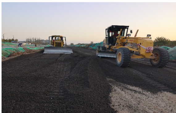
再生水泥稳定碎石铺筑现场
