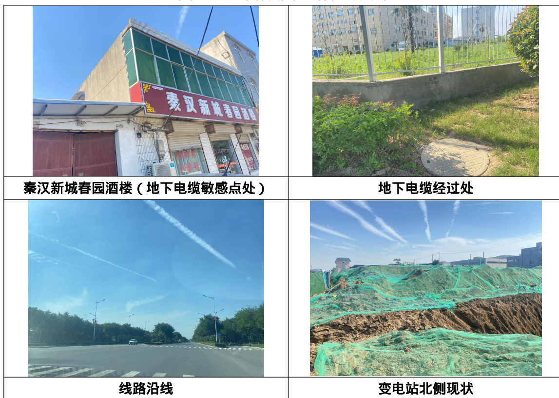
图 3-3 线路及变电站现场照片
