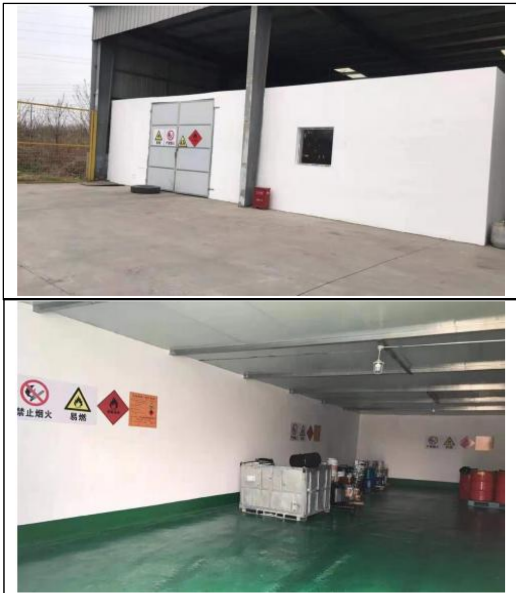
图 4-1 厂区危废暂存间
