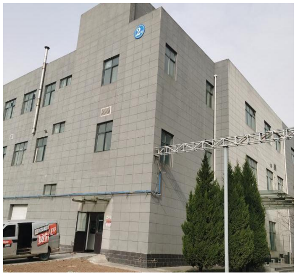
项目所在3号厂房北侧2号厂房
