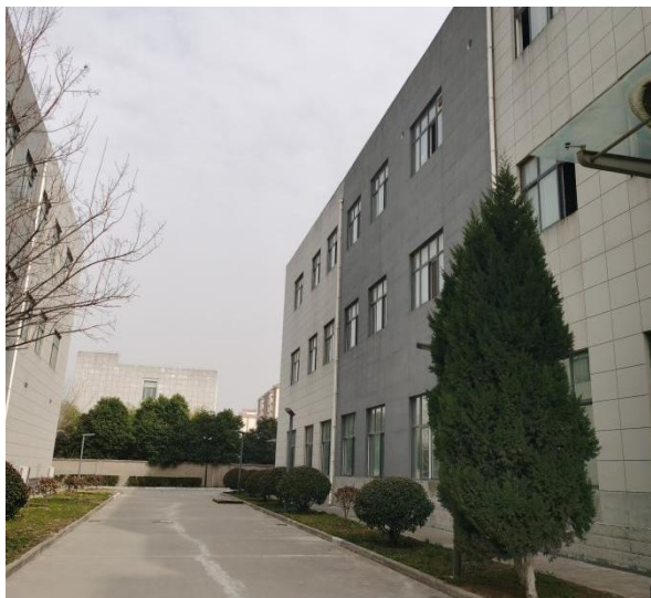
项目所在3号厂房北侧厂区道路
