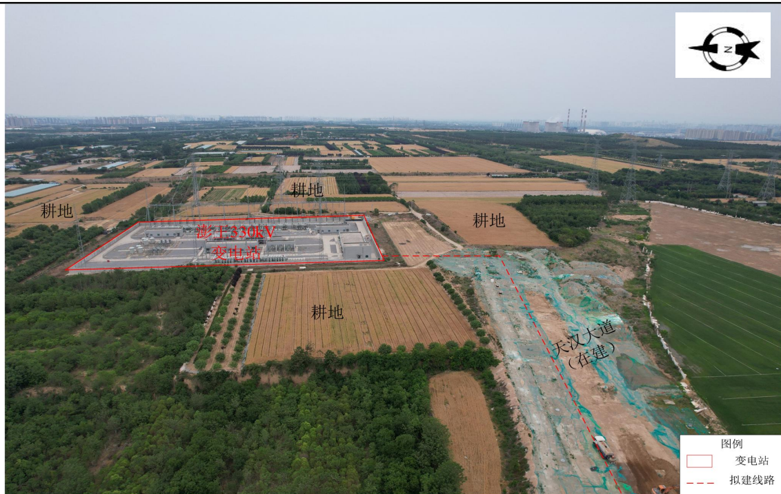
图 2-2 彭王 330kV 变电站站址四邻关系现状照片
