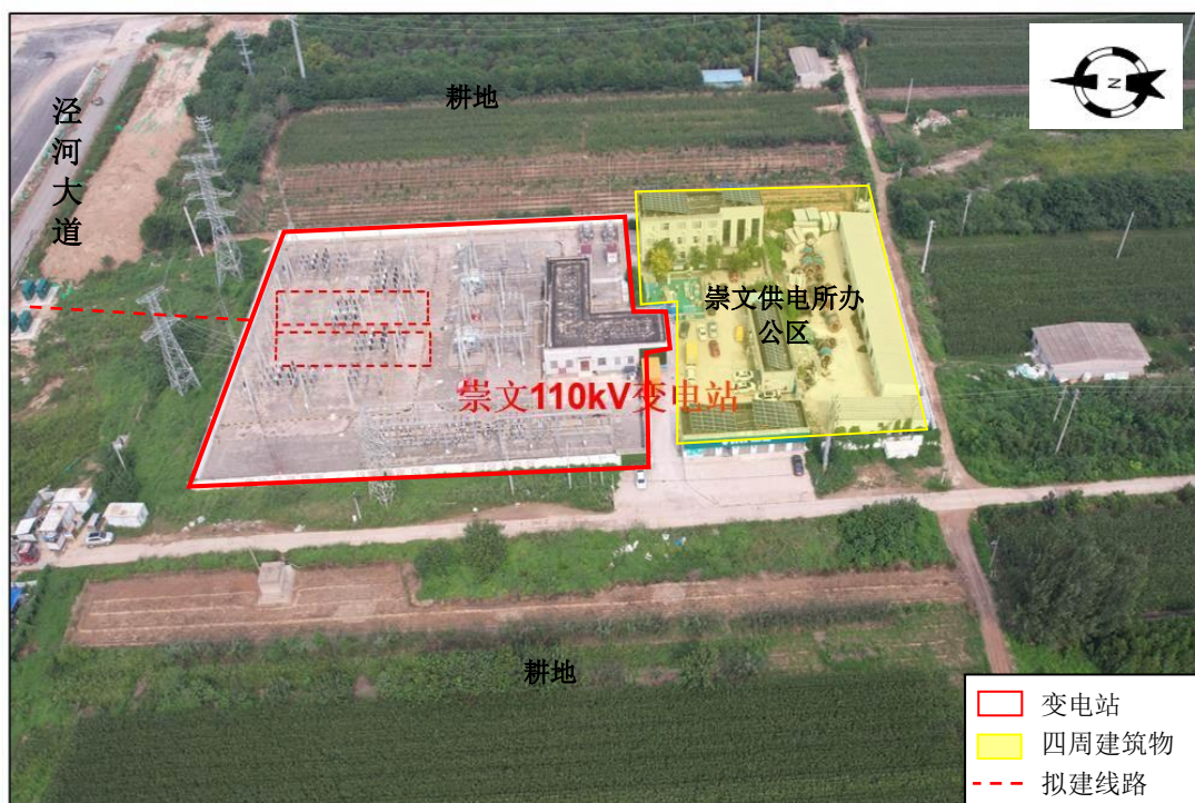
图 2-4 崇文 110kV 变电站站址四邻关系现状照片
