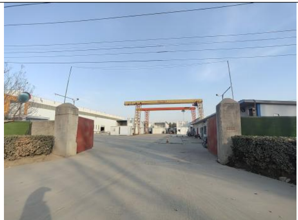
项目北侧-集装箱工厂
