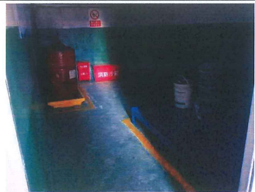
危废暂存间（内）
