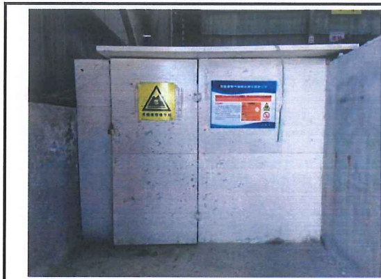
危废暂存间（外）
