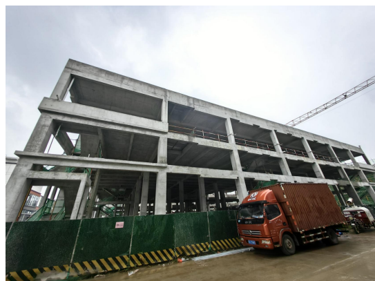
项目北侧—在建厂房
