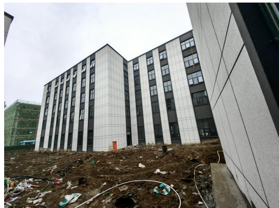
项目南侧—空厂房
