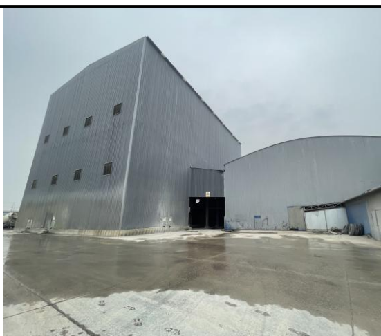
筒仓及搅拌楼密闭设置
