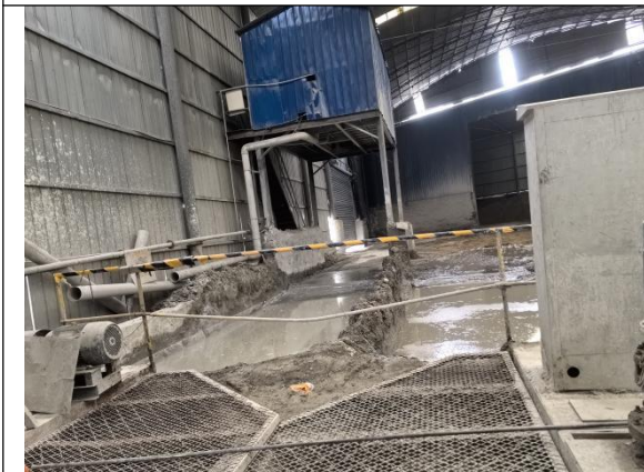
设备清洗水池
