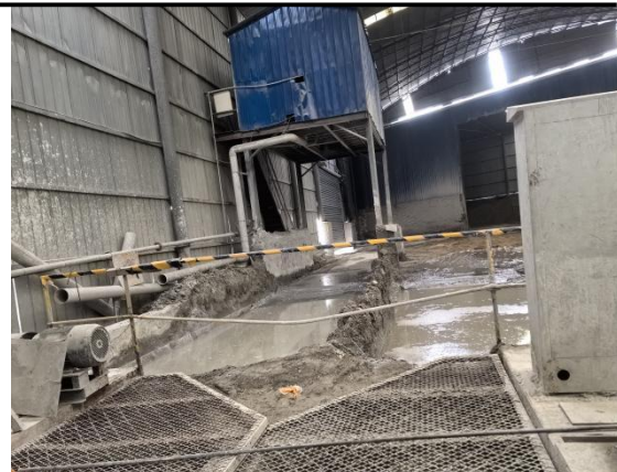
设备清洗废水沉淀池
