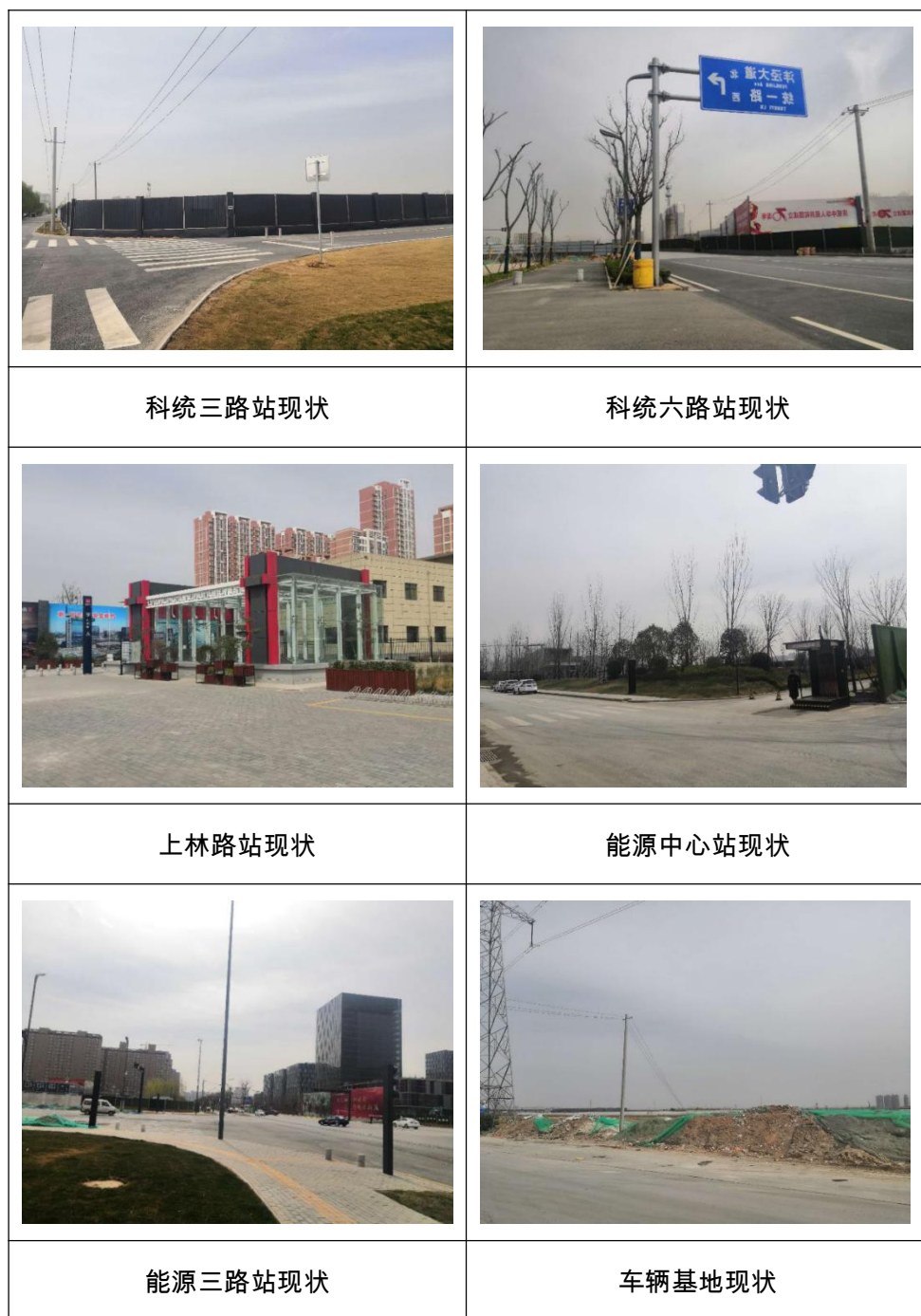
图 3.1-4 工程沿线站场现状图
