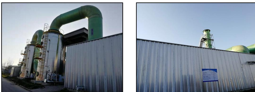
图2 厂区现有废气处置装置与排气筒
