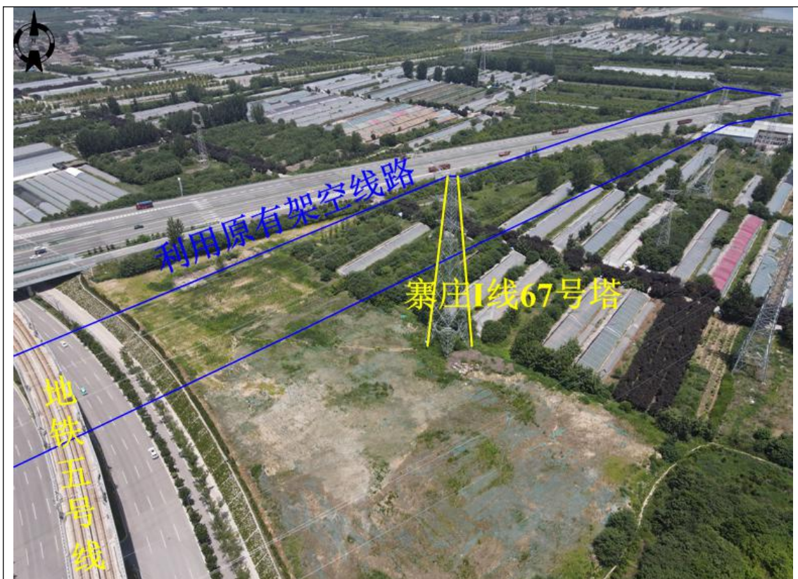
图 3-13 寨庄 1 线 67#塔现状监测点
