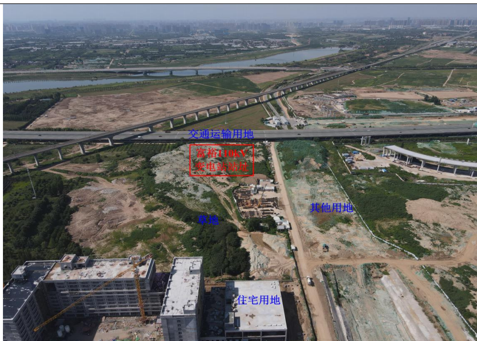
富裕 110kV 变电站站址
