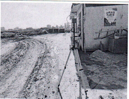
欢乐谷内部施工项目部电磁环境监测
