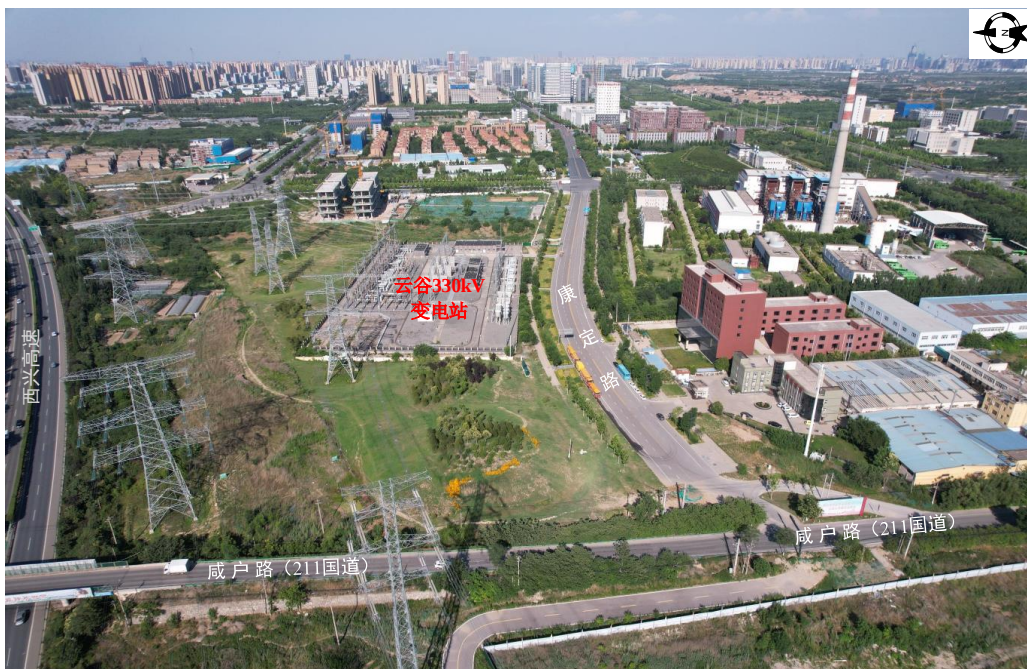
图 4.2-1 云谷 330kV 变电站周围现状
