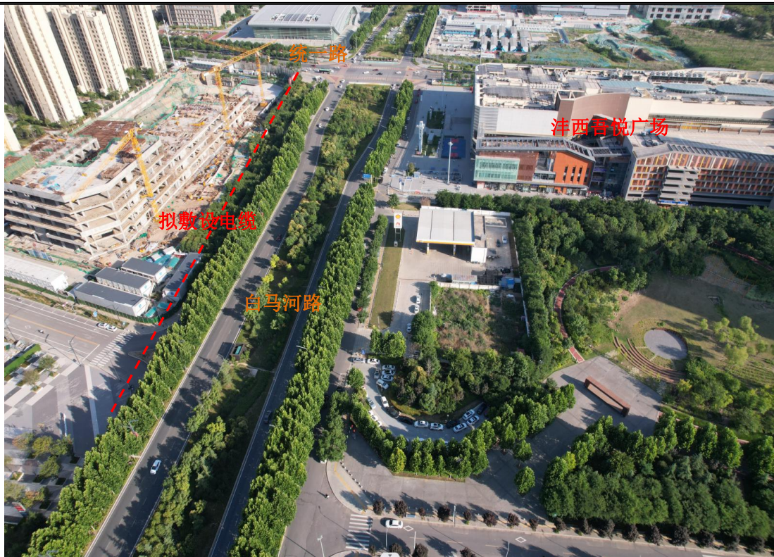
本工程现状沿线植被情况（镜头朝南）
