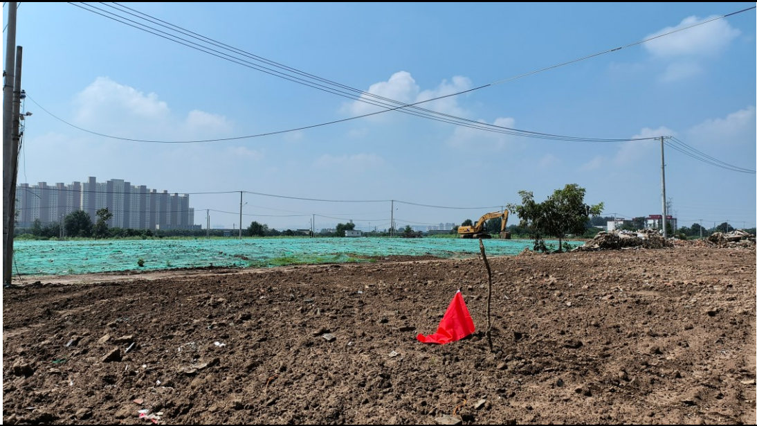
隆基 3#110kV 变电站现状
