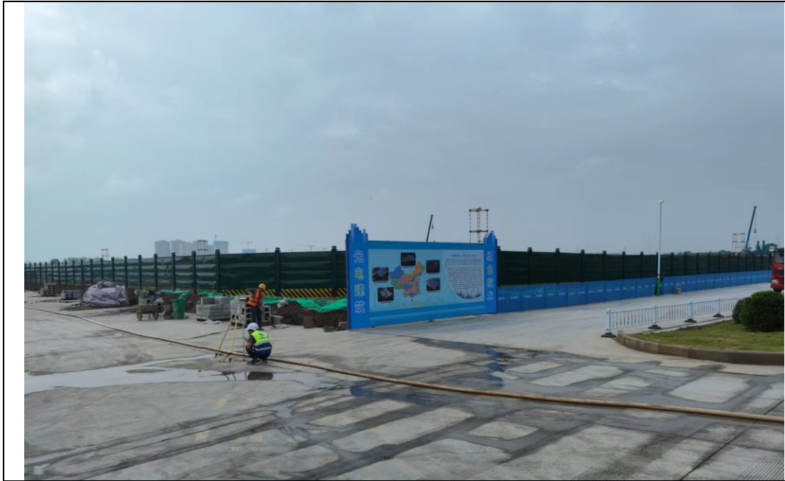
隆基 1#110 变电站现状
