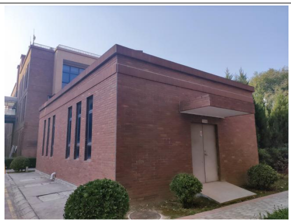
厂房东侧水泵房
