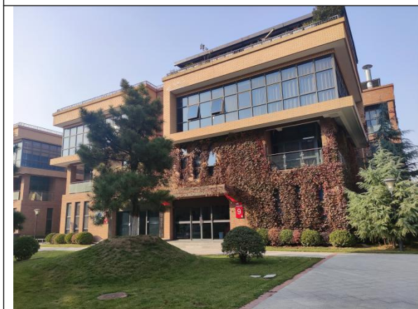
厂房北侧园区道路
