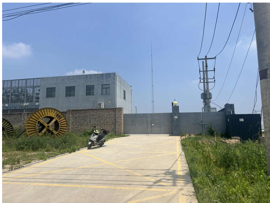
图 3-6 太平 110kV 变电站变周围现状图
