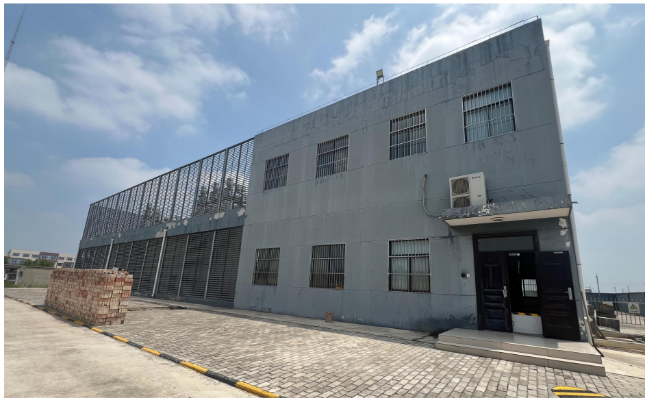
图 2-2 变电站站址现状照片
