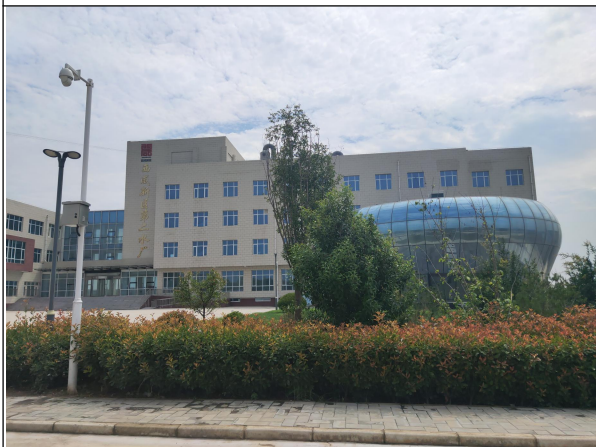
西咸新区第二水厂办公楼
