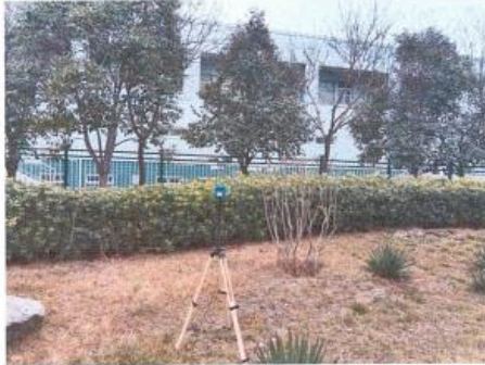
北杜 110kV 变电站外南侧间隔扩建处
