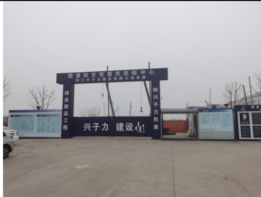
圆通速递西安转运中心南侧扩建现状照片
