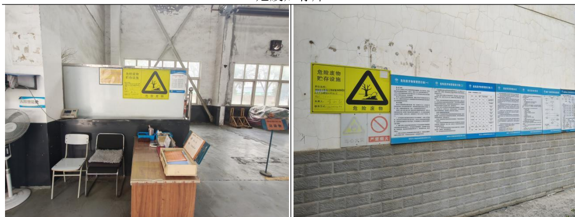
危废贮存库分区
