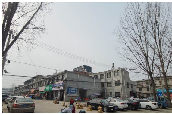
高庄 110kV 变电站西南侧高庄二队居民
