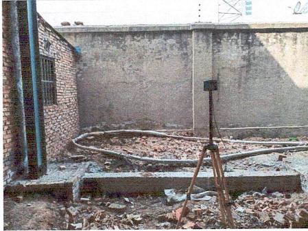
高庄 110kV 变电站东厂界
