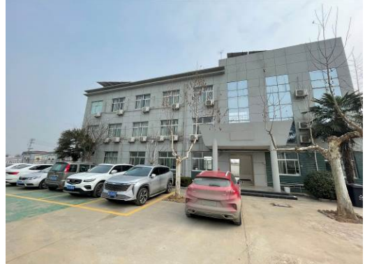
崇文 110kV 变电站南侧办公楼 1
