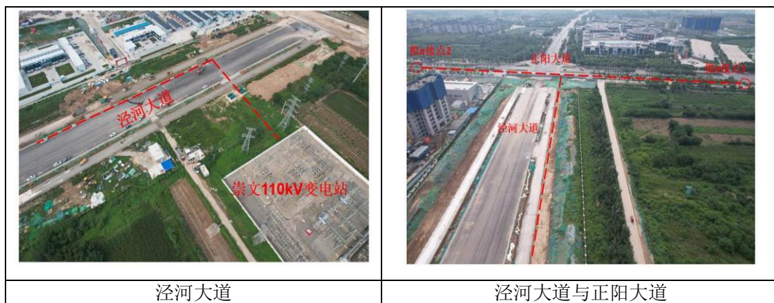
图 2-13 永东~高庄线路 \pi 入崇文变 110kV 线路工程沿线现状示意图
