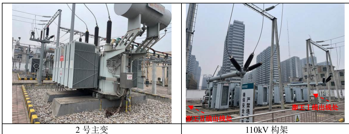
图 2-7 高庄 110kV 变电站内部分设施现状
