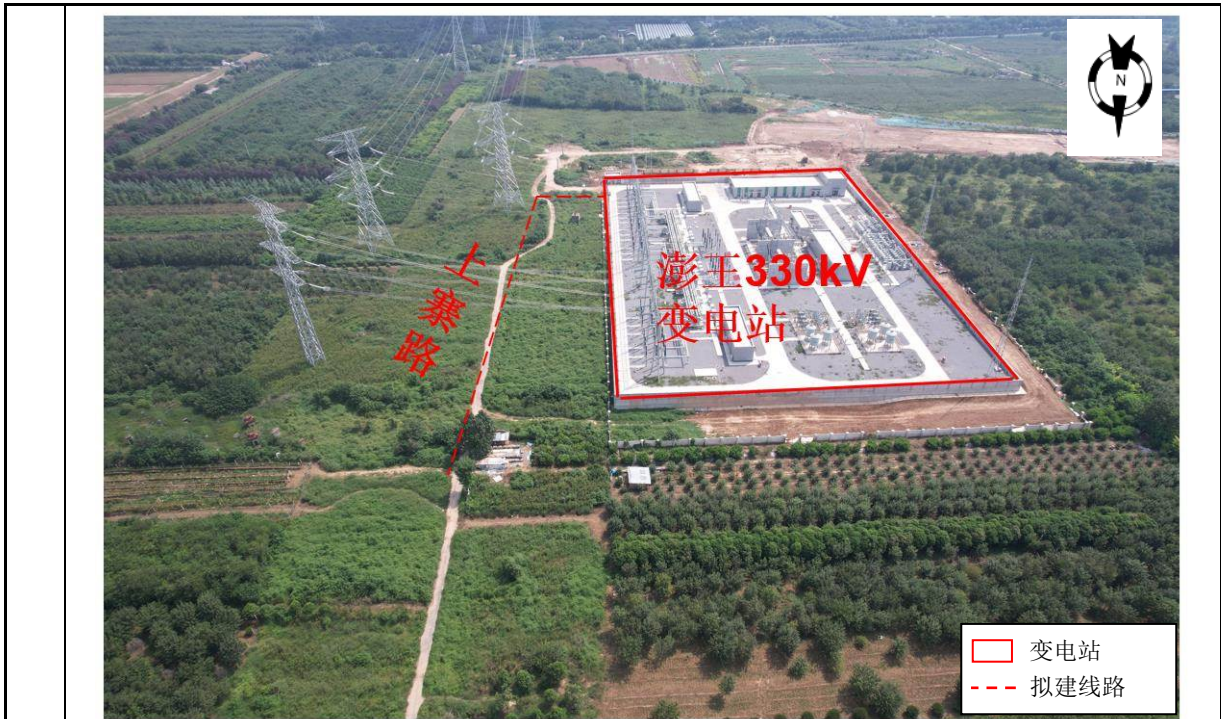
图 2-2 彭王 330kV 变电站站址现状照片
