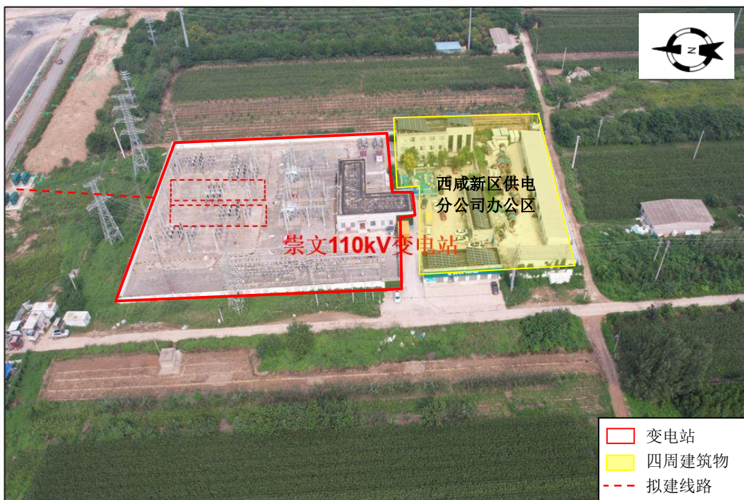
图 2-4 崇文 110kV 变电站站址现状照片
