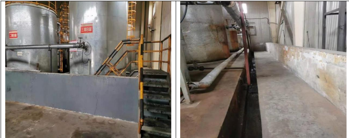
芳烃油储罐区围堰
