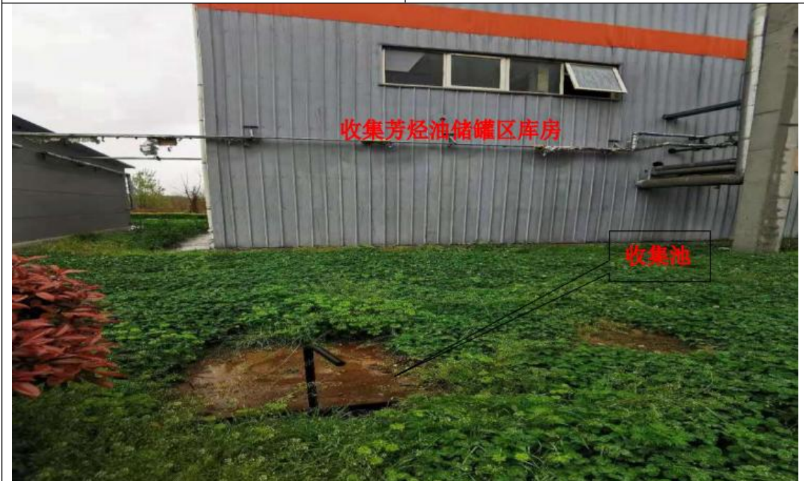
芳烃油罐区库外事故收集池
