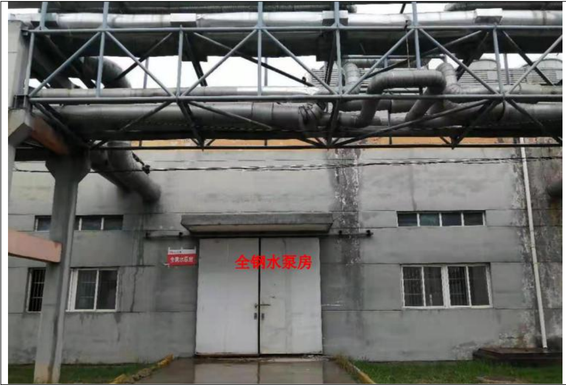
消防水池（位于全钢水泵房下面）
