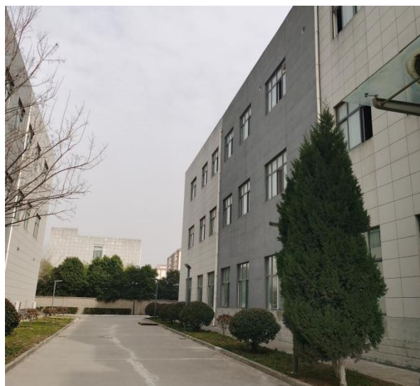
项目所在3号厂房北侧厂区道路
