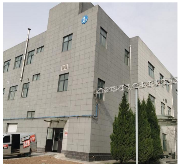
项目所在3号厂房北侧2号厂房
